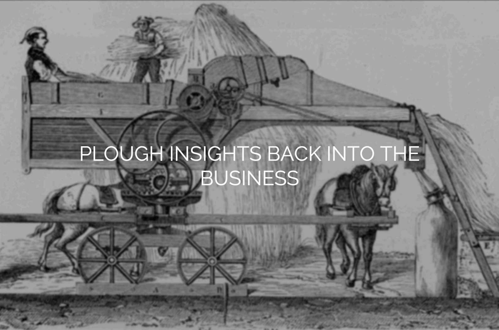
Fig. 349. — Batteuse Damey à manège direct placé sous la batteuse.
